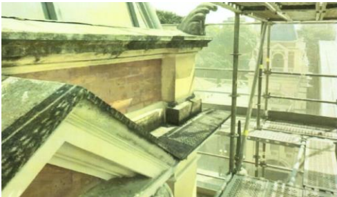
Limpeza de cimalkhas dos torreões
