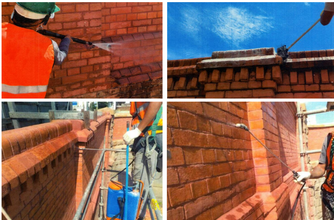
Aplicação de detergente neutro, limpeza e aplicação de hidrofugante. Fonte: Relatórios Mensais, Sarasá.
