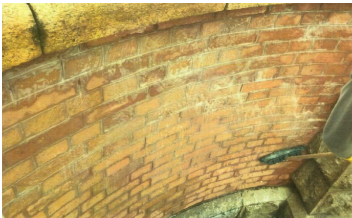
Aplicação de detergente neutro e limpeza. Fonte: Sarasá
