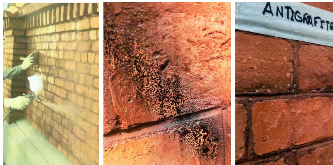
Aplicação de hidrofugante antipichação nos muros externos. Fonte: Relatórios Mensais, Sarasá.
