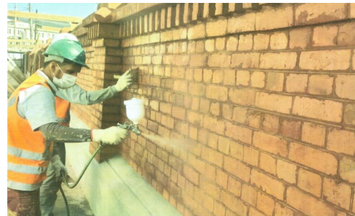
Aplicação proteção a base de silanos para respirabilidade. Fonte: Sarasá
