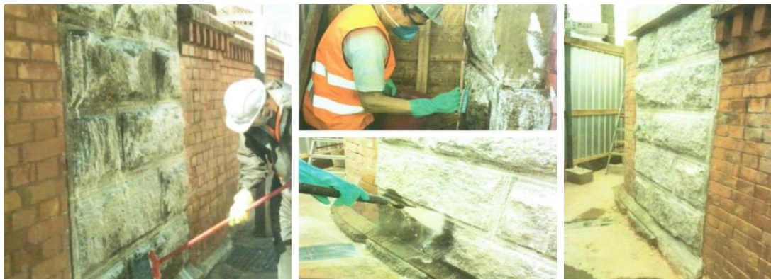
Intervenções nas cantarias. Fonte: Relatórios Mensais, Sarasá.
