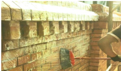
Limpeza técnica nos muros
