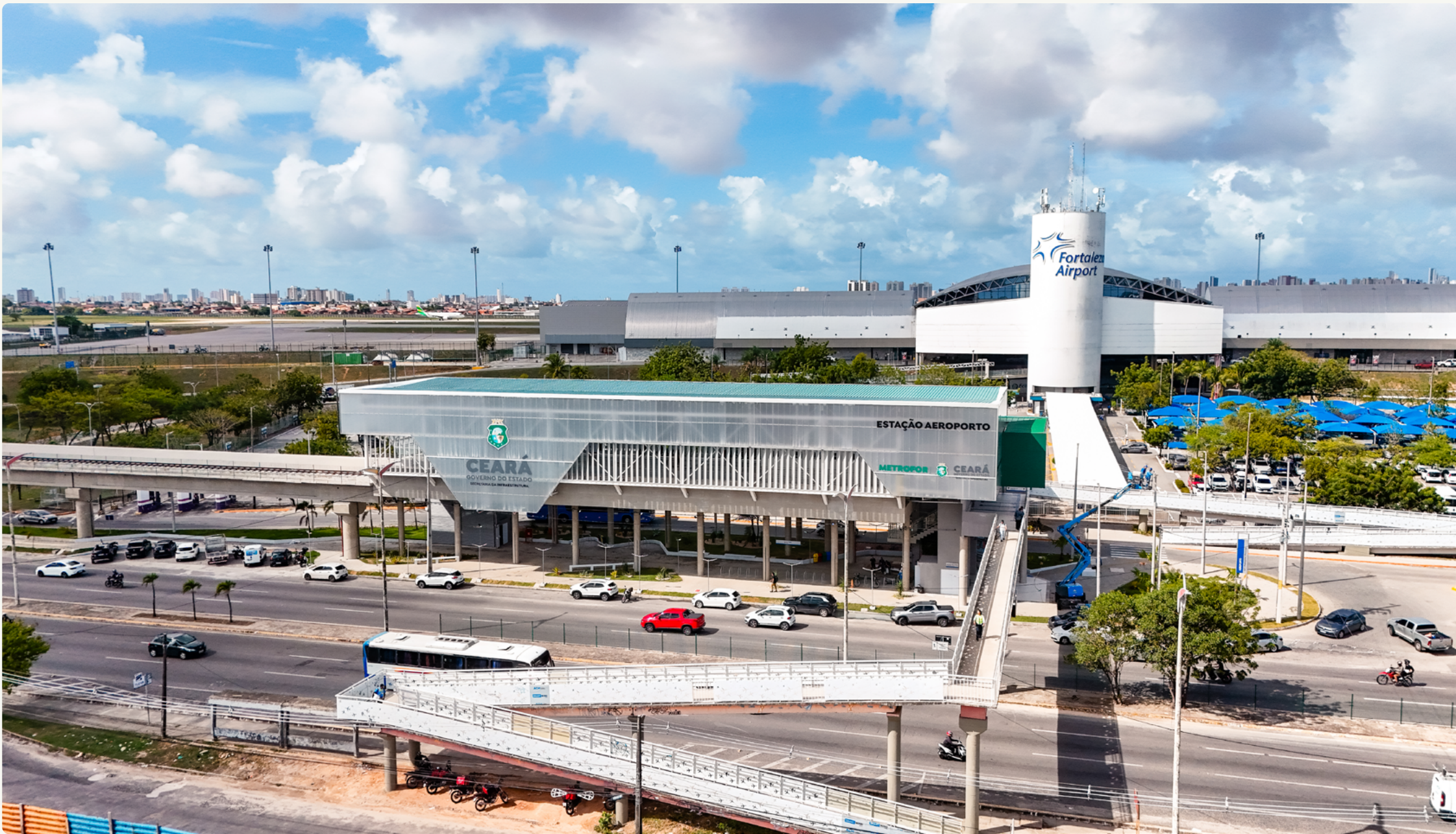
Ramal Aeroporto do VLT de Fortaleza ou Estação Aeroporto.
