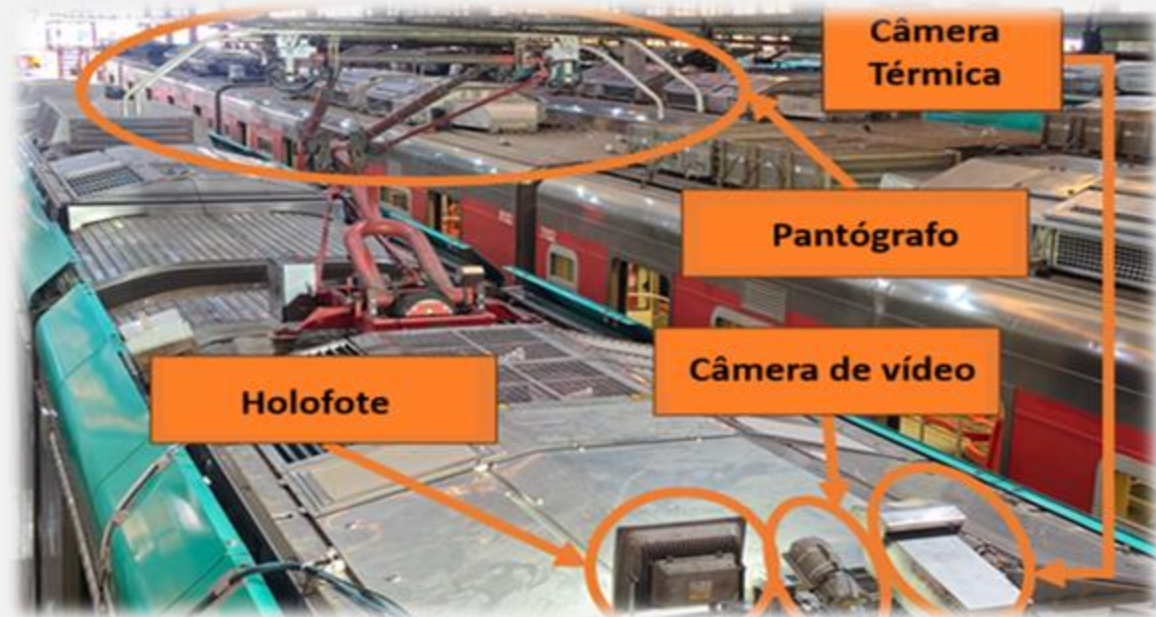
Câmara com projetor e câmara térmica no teto do pantógrafo de registo do comboio (sistemas de corrente, tensão, arco, elevação e termografia).
