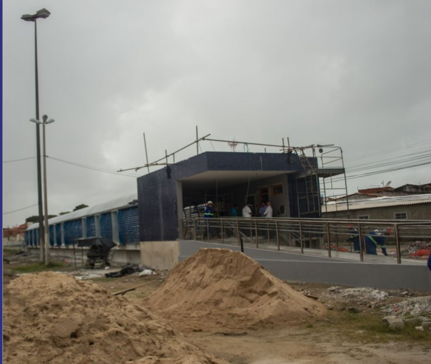
Figura 03: Construção da Estação Jaraguá em 2017. Fonte: Acervo CBTU
