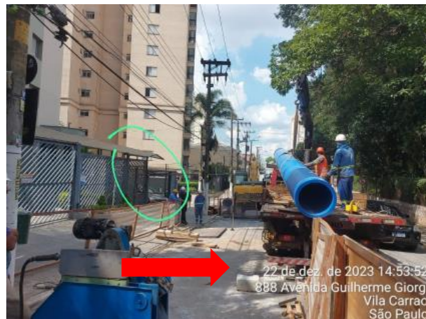
Figura 20 - Fila de veículos aguardando descarregamento de tubulação para liberação do acesso
