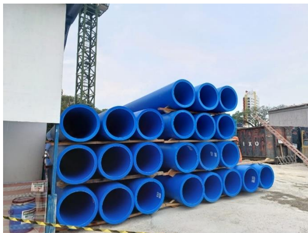
Figura 27 - Armazenamento de tubos
