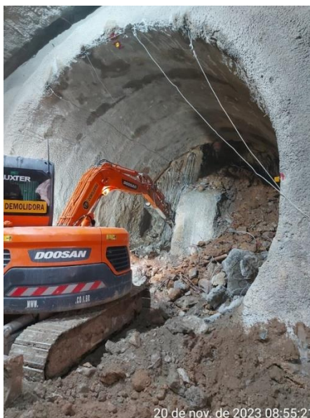
Figura 12 - Execução túnel piloto
