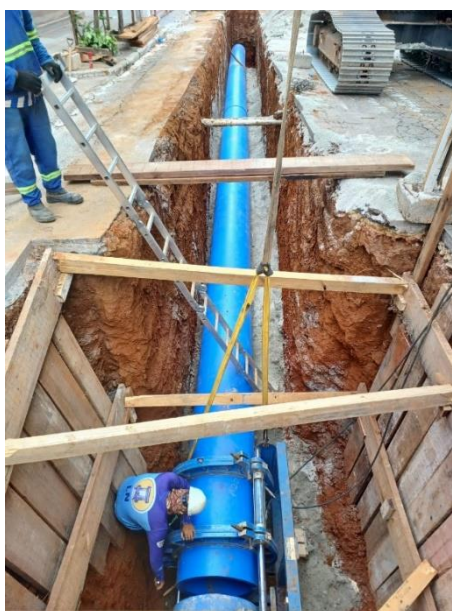
Figura 32 - Execução de solda em vala
