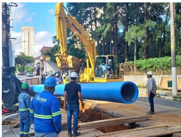
Figura 29 - Lançamento de tubo PEAD
