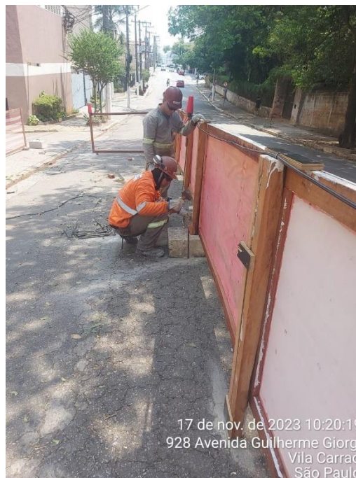
Figura 14 - Montagem do desvio de tráfego
