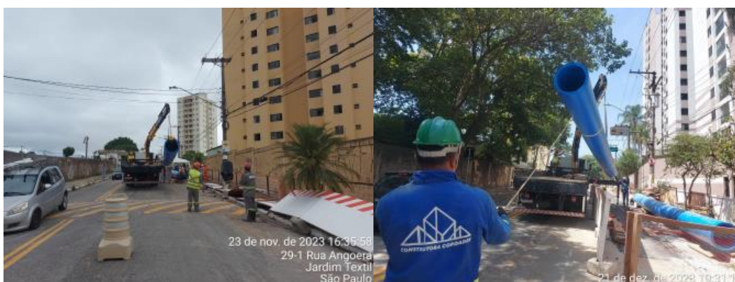
Figura 19 - Bloqueio de avenida para descarga de tubo PEAD
