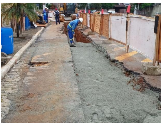
Figura 33 - Aterro da tubulação
