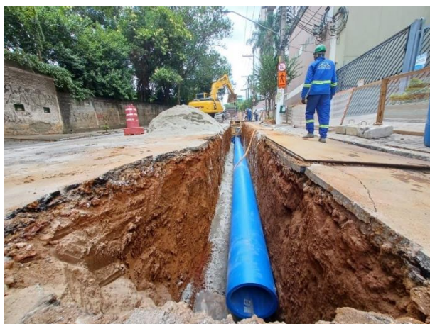
Figura 30 - Tubo acomodado sobre berço de areia
