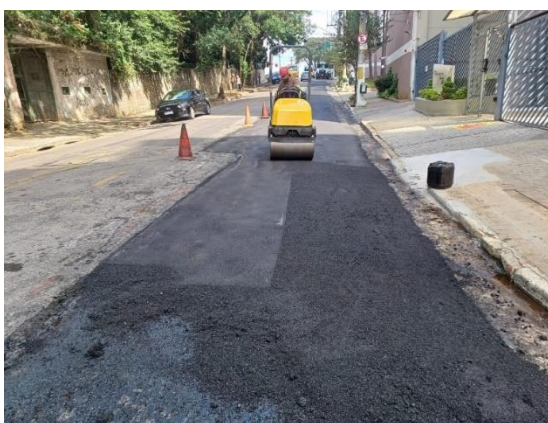
Figura 34 - Recomposição da pavimentação
