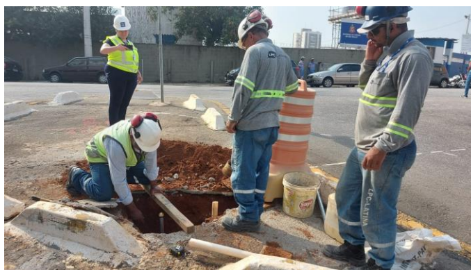
Figura 25 - Instalação de instrumento na adutora para monitoramento
