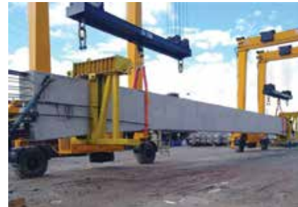
Figura 14 - Transporte da viga-guia para colocação na linha de eixo
