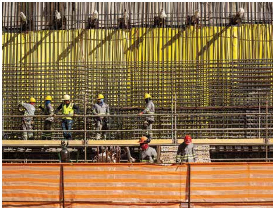
Obras de expansão da Linha 2-Verde do Metrô-SP
