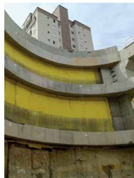
Figura 10 - Aplicação da geomembrana de PVC sobre o revestimento primário
