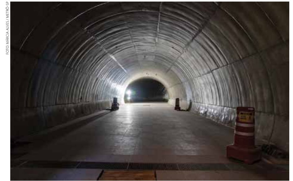
Túnel de ligação Aeroporto de Congonhas, Linha 17-Ouro
