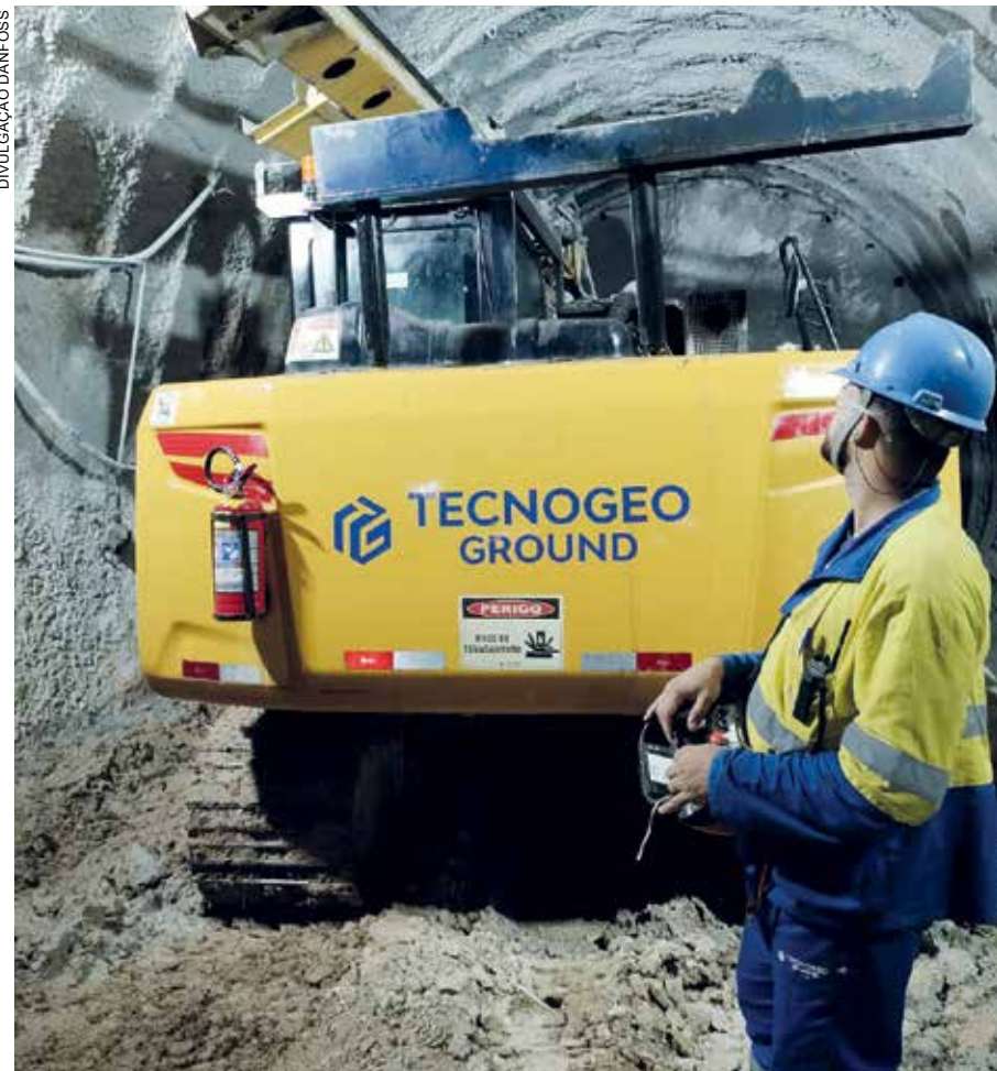
iDrill obtém precisão e segurança em operação remota de perfuratriz com rádio controle nas obras do Metrô de São Paulo
