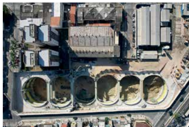
Figura 1B - Estação Aricanduva em construção
