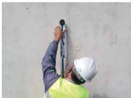
Figuras 10 e 11 - Verificações dimensionais na viga-guia
