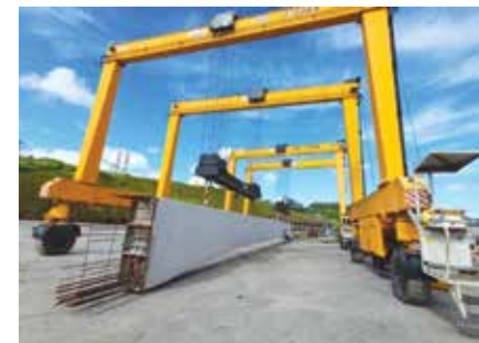
Figura 5 - Movimentação da viga-guia na fábrica
