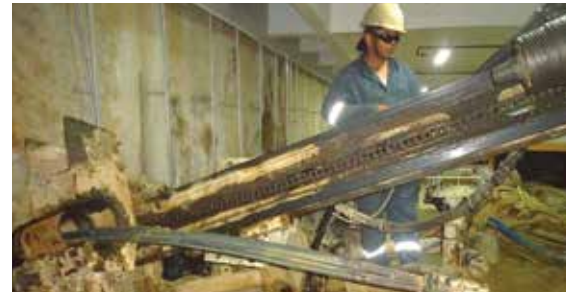
Figura 16 - Retirada das cordoalhas dos tirantes
