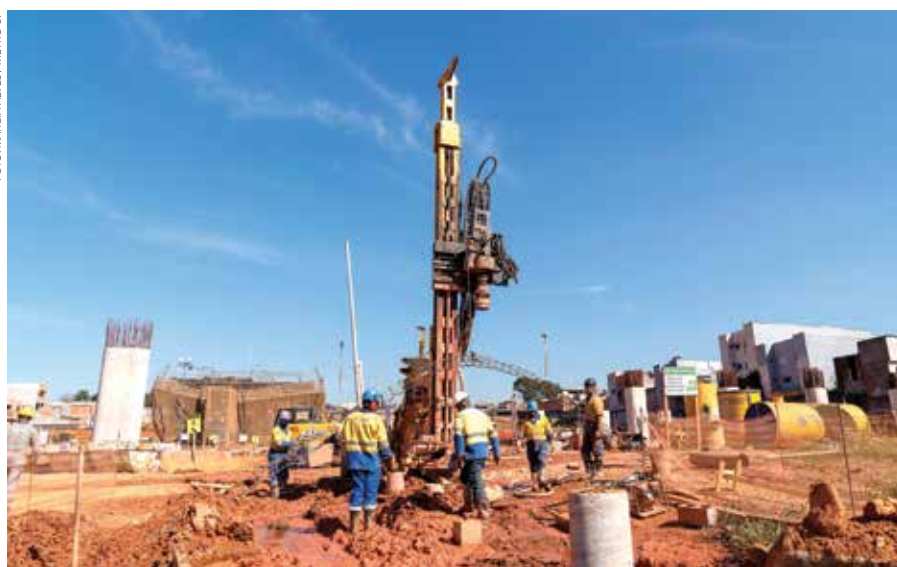
Obras Pátio Ragueb Chohfi, Linha 15-Prata
