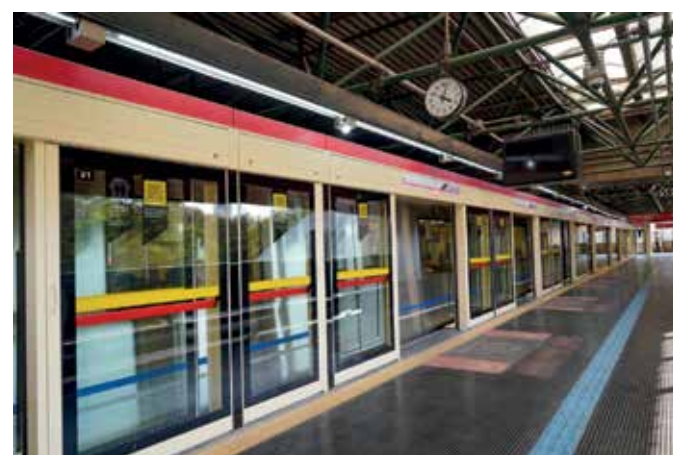
Montagem de Portas de Plataforma Modular na Linha 3-Vermelha, Metrô de São Paulo
