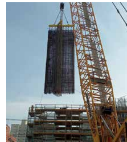
Figura 4B - Montagem da armação dos Barretes em formato de seta
