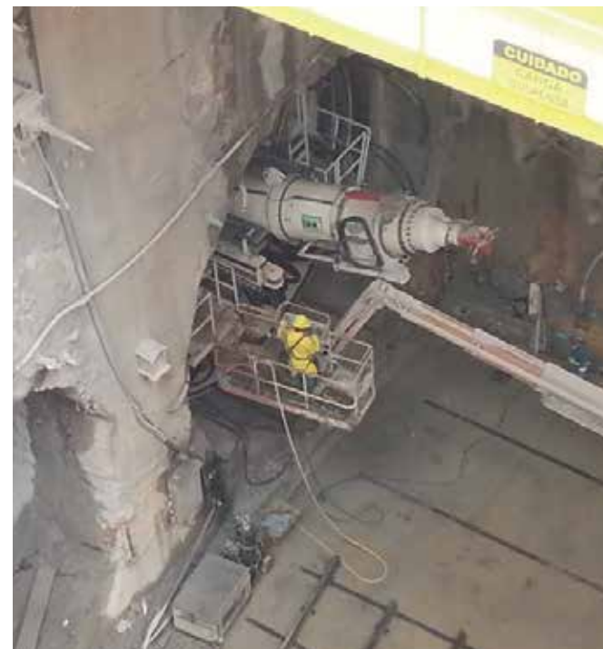
Figura 13 - Montagem da tuneladora “Tarsila” no emboque da Via 1 no sentido Alto da Boa Vista (foto: Luiz Taqueda, 04/10/2013)
