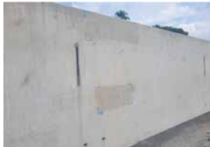
Figura 13 - Correções dimensionais na viga-guia
