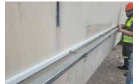
Figuras 8 e 9 - Verificações dimensionais da viga-guia
