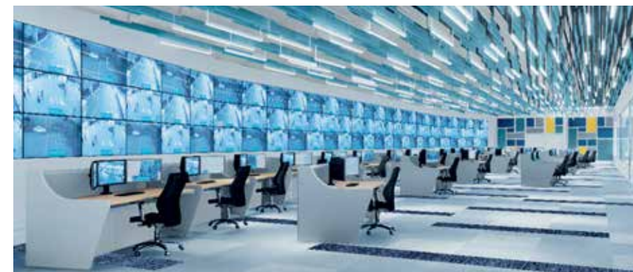
Figura 1 - Projeção do Centro de Controle após a reforma
