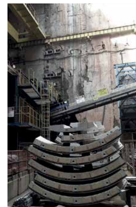
Figura 9 - Interior da VCA Conde de Itú (Foto: Luiz Taqueda, 19/08/2015)
