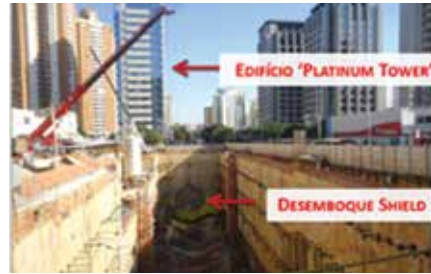
Figura 14 - Vista geral do local com edifício e TBM
