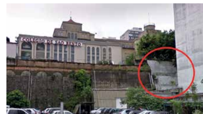
Figura 5 - Muro de contenção
