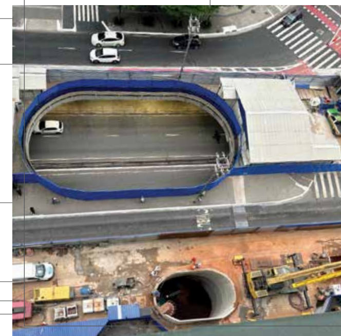
Túnel de Conexão Linhas 2 e 4 - Metrô SP
