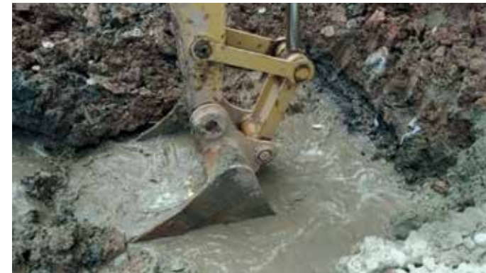
Figura 11 - Escavação de solo mole na Estação Aricanduva
