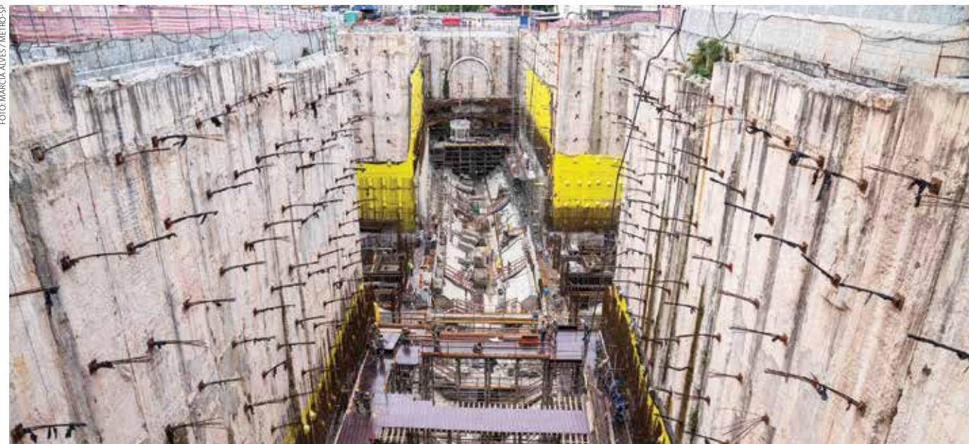
Obras Guilherme Giorgi, Linha 2-Verde
