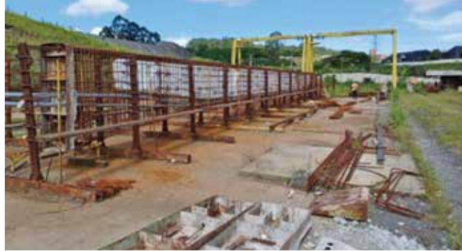
Figuras 1 e 2 - Montagem de armações e componentes da viga-guia
