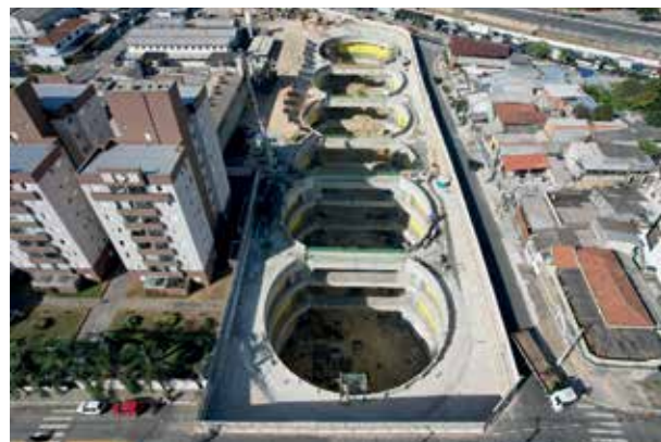
Figura 1A - Estação Aricanduva em construção
