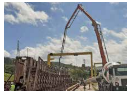
Figura 3 - Concretagem da viga-guia
