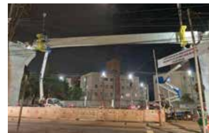
Figuras 15 e 16 - Lançamento de viga-guia no período noturno
