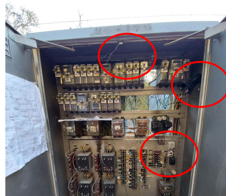
Sistema de alarme sonoro para reconhecimento de abertura indevida de porta.
