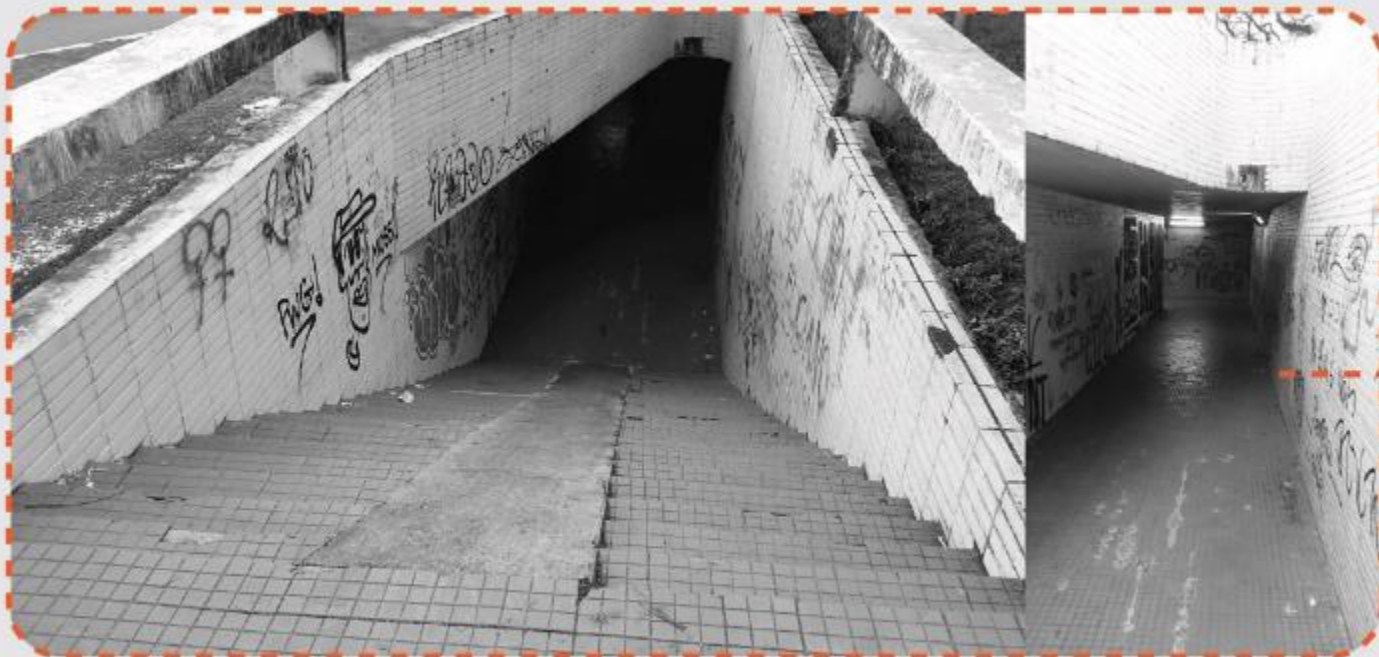
Passagem subterrânea existente - Asa Sul
