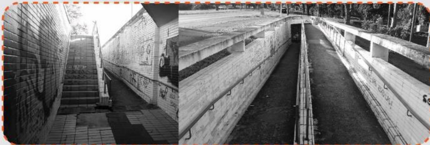
Passagem subterrânea existente - Asa Norte
