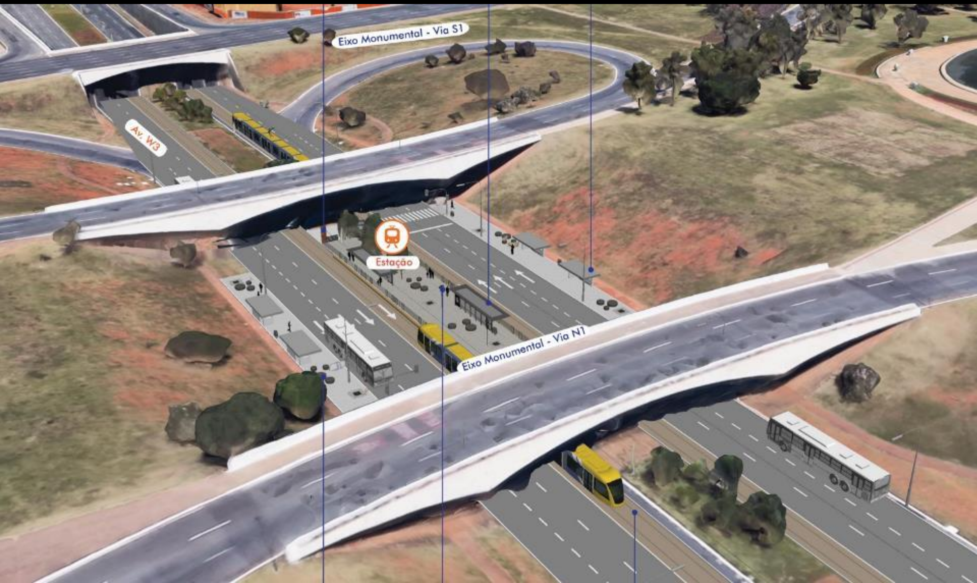
ESTAÇÃO NO CRUZAMENTO COM O EIXO MONUMENTAL
