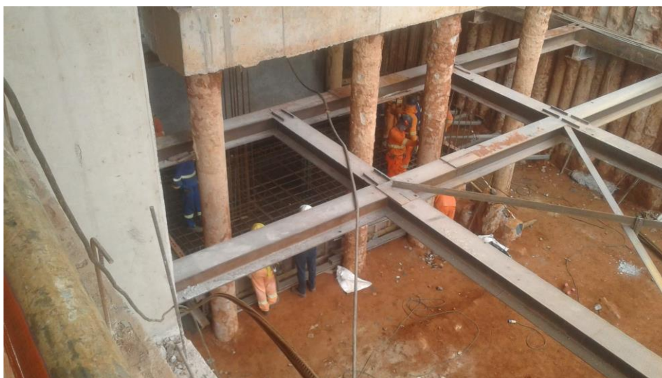
Figura 19 - Armação do bloco definitivo dos pilares PN6 e PN7 para posterior concretagem.
