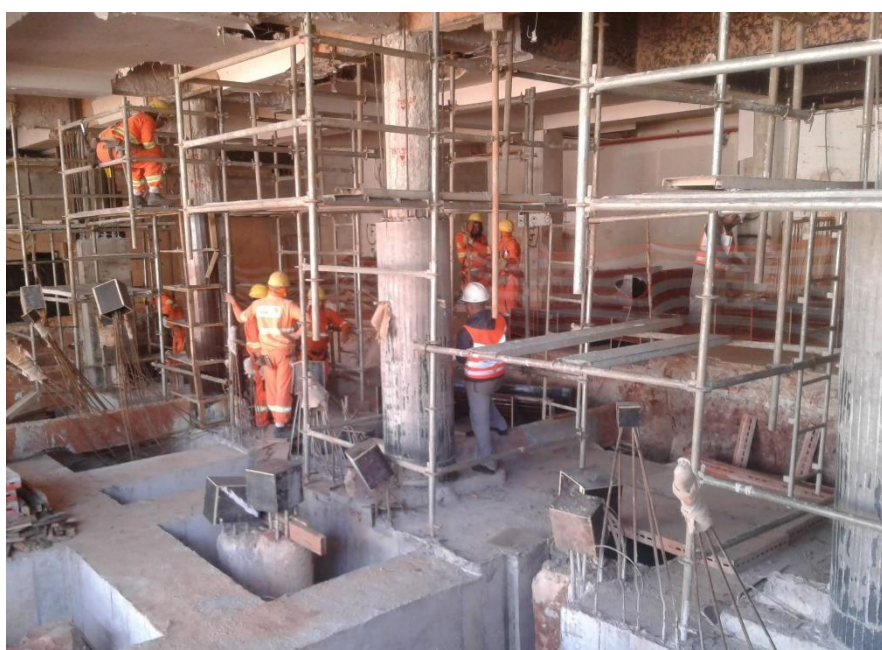
Figura 10 - Vista dos pilares PE1 a PE4 com as vigas de coroamento já devidamente concretadas.
