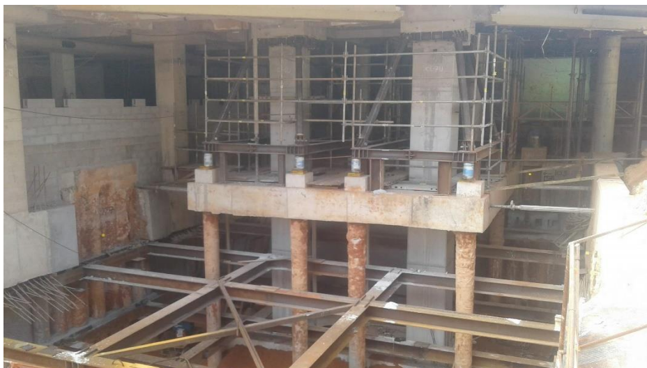
Figura 18 - Pilares PN6 e PN7 finalmente concretados e pronto para serem descarregados.
