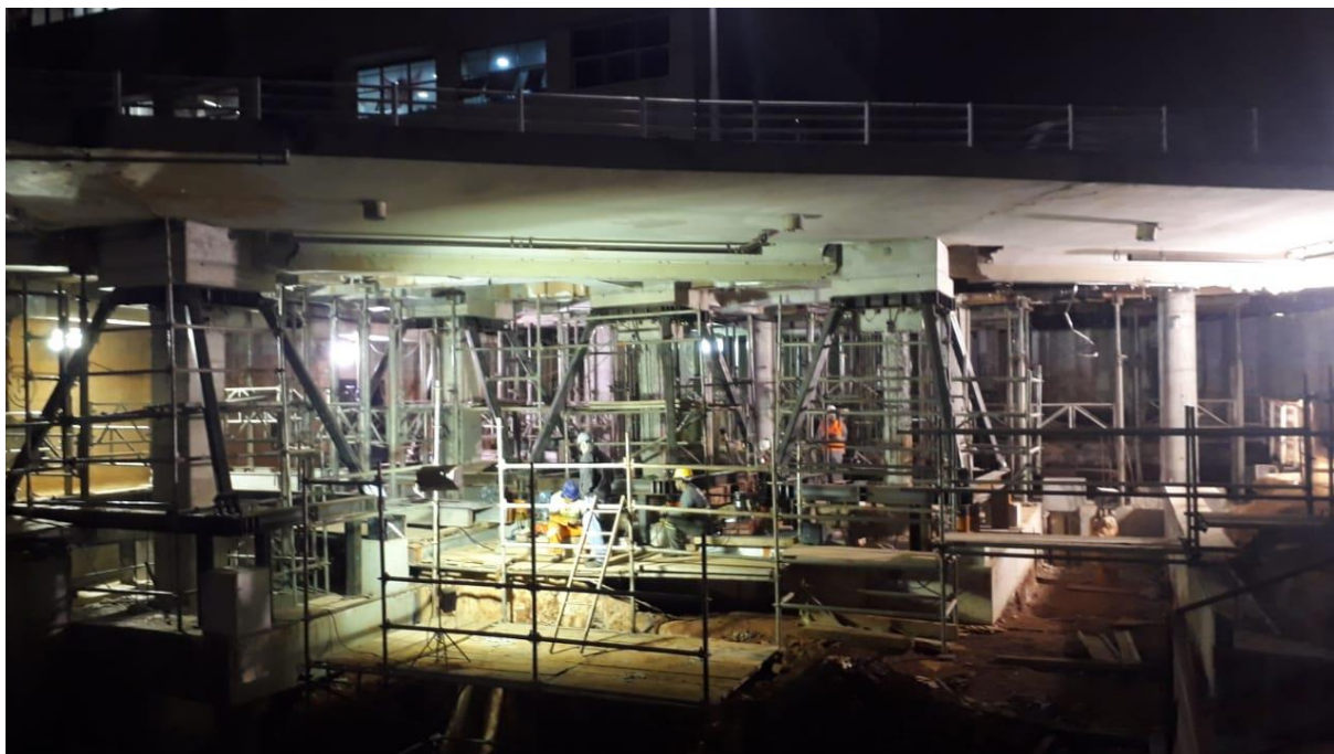
Figura 15 - Preparação para carga dos pilares PE6 e PE7.
