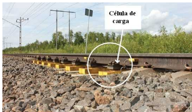
Figura 13 – Detector de carga de impacto de rodas utilizando células de carga (ASPLUND, 2014)
